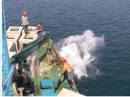
Şekil 3. Yapay resif bloklarının taşınması ve suya bırakılması
