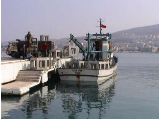
Şekil 3. Yapay resif bloklarının taşınması ve suya bırakılması
